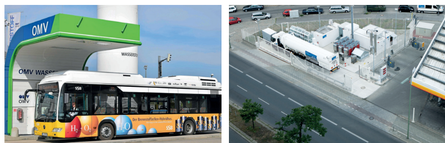
ABBILDUNG 1-1 Beispiele für Wasserstofftankstellen (Clean Energy Partnership): links OMV-Tankstelle am Flughafen Stuttgart mit einem Niederdrucktank (stehender Behälter im Hintergrund) rechts Shell-Tankstelle in Berlin mit Flüssig-H 2 -Trailer (vorne) und Hochdruckbänken (hinten)
